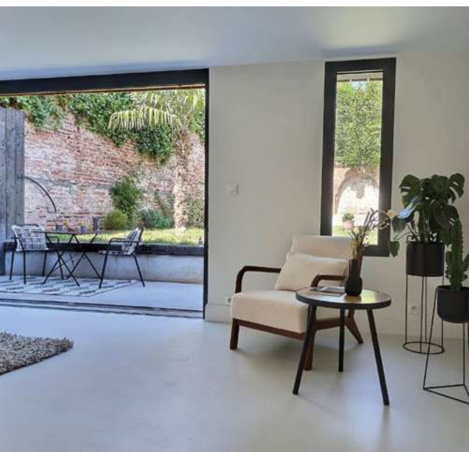
Dedans-dehors. L'ouverture en accordéon de 4 mètres de la baie vitrée fait profiter du jardin depuis l'intérieur. Le dormant est en bois brûlé. Au sol, béton blanc cassé recouvert de résine époxy.
