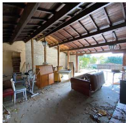
Au avant travaux, réhabilité en suite parentale après le chantier.
