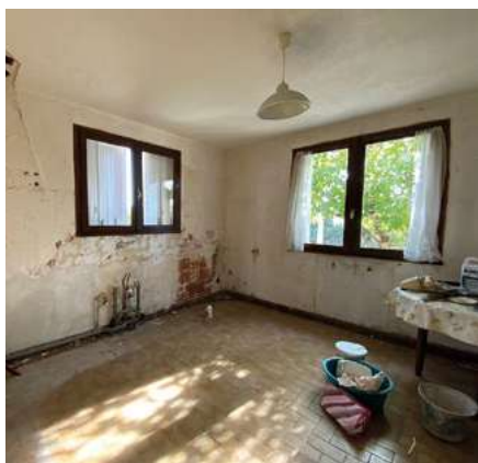
Cuisine avant travaux.
