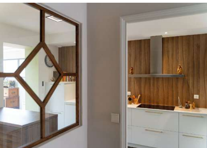
Focus sur la verrière réalisée en bois.
