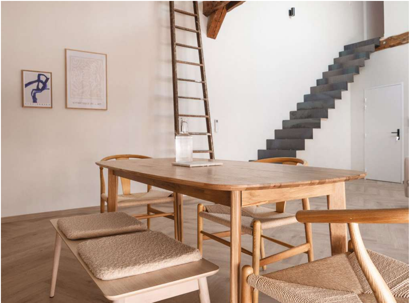
La Métallerie Bardy de Castres a réalisé l'escalier en tôle pliée qui conduit à une chambre. Brut et léger, il se mesure à l'échelle en bois, témoin du passé. On l'utilisait ici même pour accéder aux archives de la banque.
