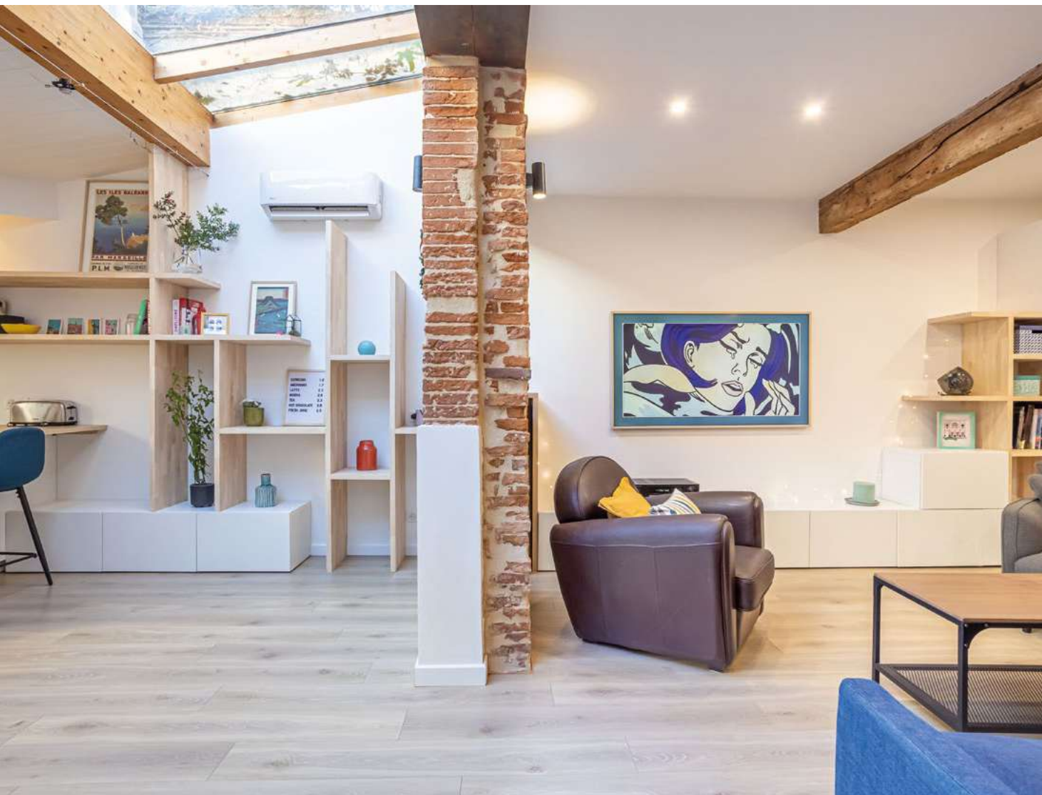
Vue de coupe sur l'ancien mur porteur. Les piliers sont à présent reliés par un IPN. Les verrières au plafond sont remises à neuf pour une meilleure isolation. Un système de climatisation réversible est installé. Le meuble sur-mesure vient se confondre avec les éléments de la cuisine.
