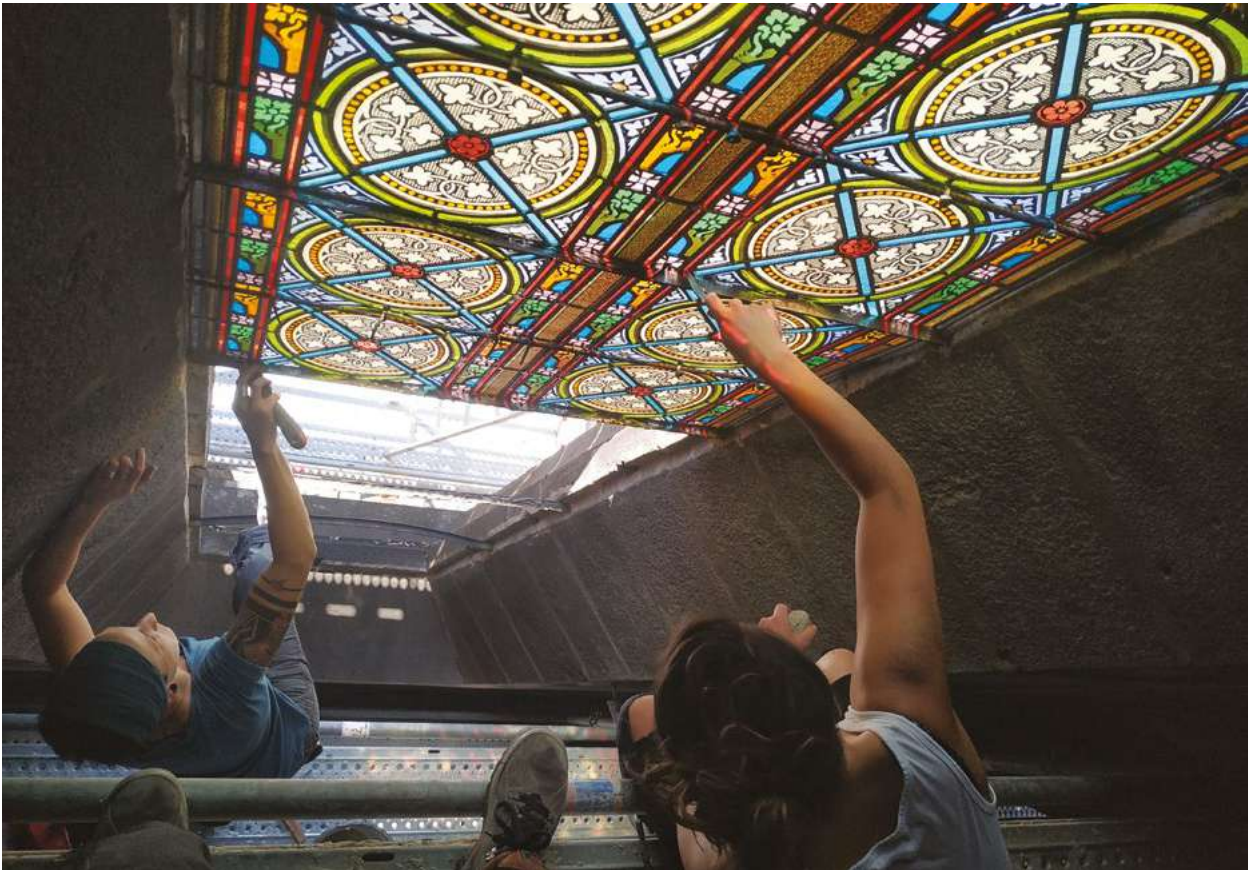
Pose des vitraux du XIX e siècle rénovés à l'église Sainte-Christine dans la commune de Saint-Flour, dans le Cantal.
